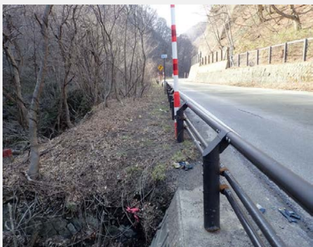
▲防護柵 着手前
