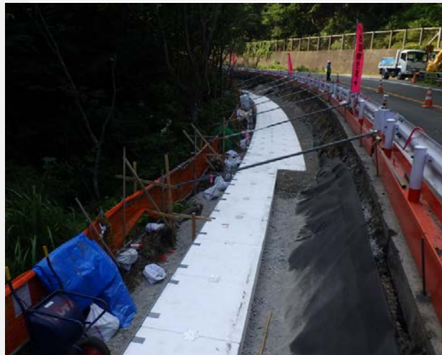
▲軽量盛土 施工中
