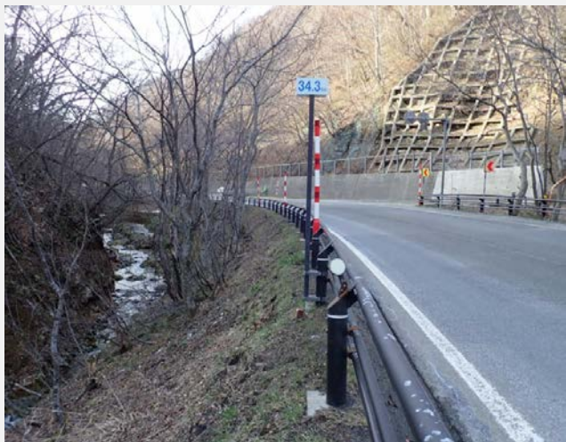
▲軽量盛土 着手前
