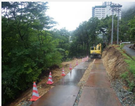
▲工事用道路起点側
