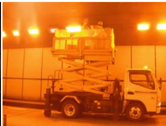
照明灯点検状況
