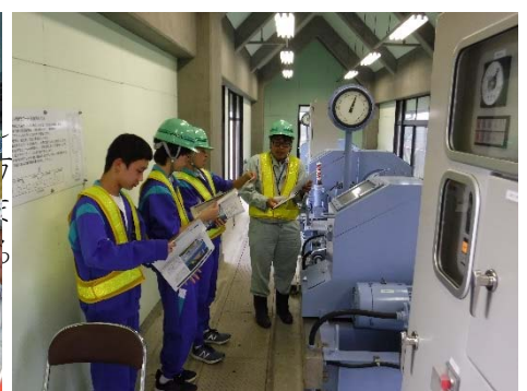
樋門の役割を説明(筑川樋門)
