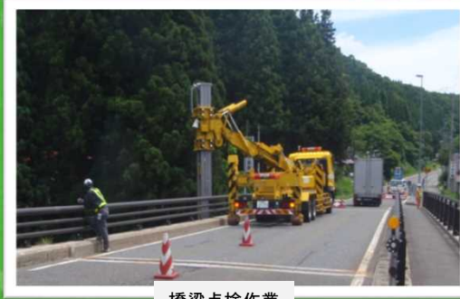
橋梁点検作業
