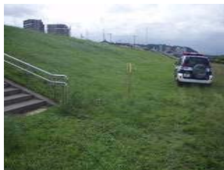
車上からの河川巡視
