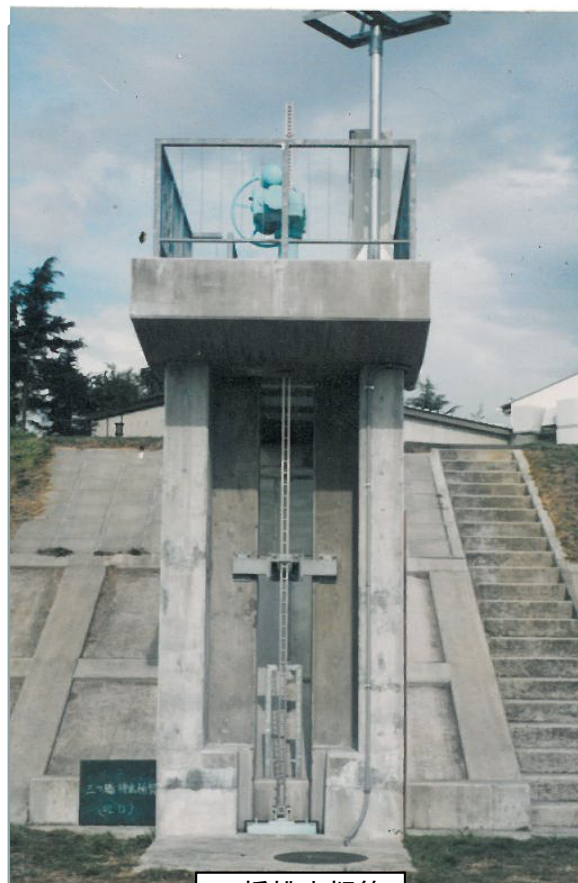
三橋排水樋管
