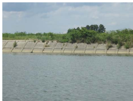
船上巡視による護岸点検
