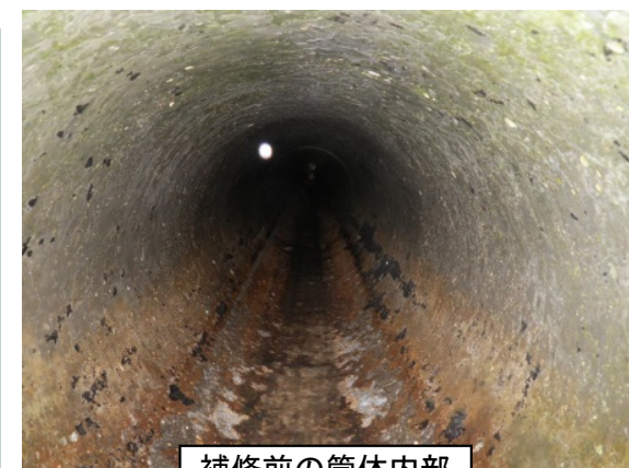
補修前の管体内部
