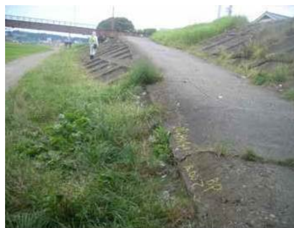
護岸点検状況
