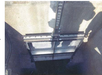
補修後(扉体ステンレス化)
