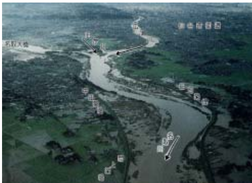
広瀬川合流点付近の氾濫と浸水状況
