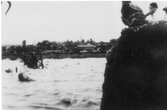
評定河原橋の流出
