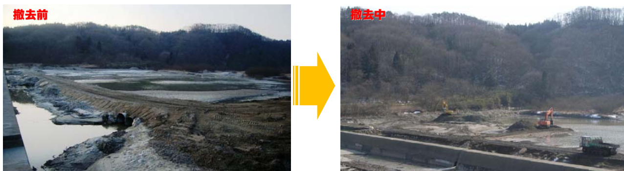
土砂撤去の状況（貯砂ダム）
