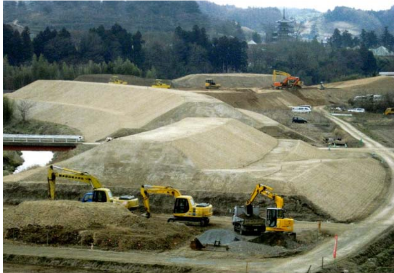
写真は「阿武隈川左岸油井地区築堤工事」の事例
