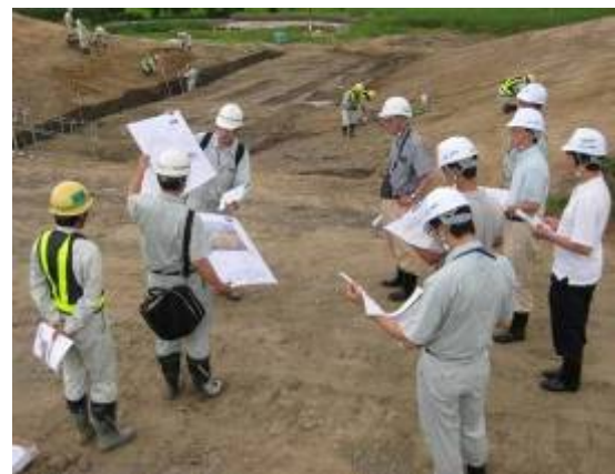
堤防被災の原因調査状況
