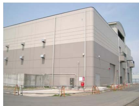
長町第一ポンプ場（仙台市下水道）
