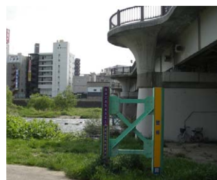
危険水位表示板（広瀬橋）
