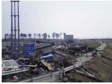
被災状況 (河口から左岸 2.0k 付近、 仙台市若林区日辺地先)
