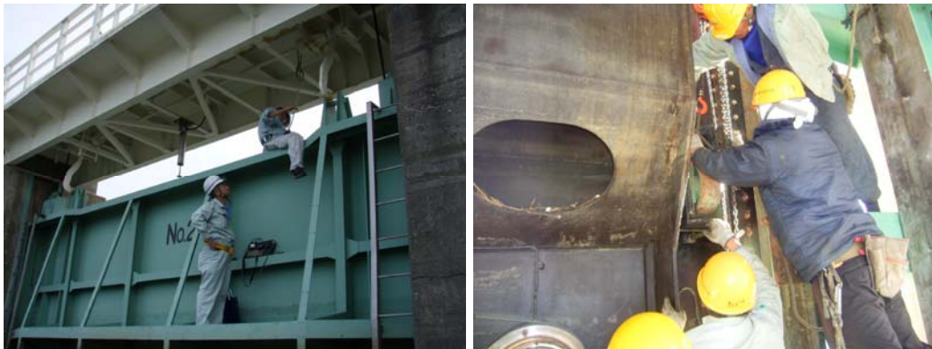
樋門・水門点検状況
