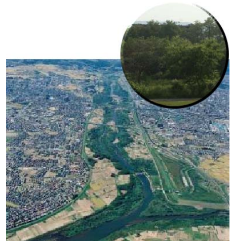
河道内樹木の状況
