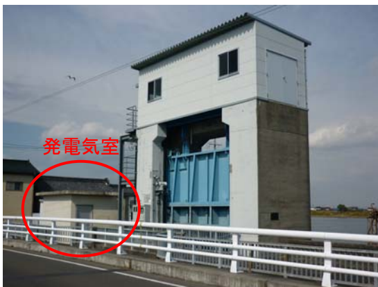
閉上水門(地震前)
