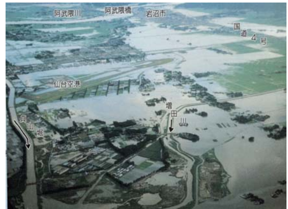
仙台空港周辺の浸水状況
