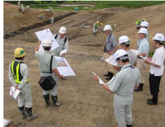
堤防被災の原因調査状況
