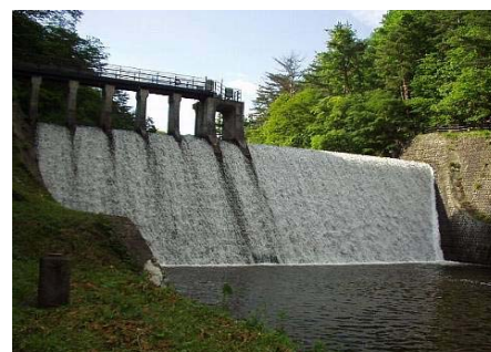
青下第二ダム
