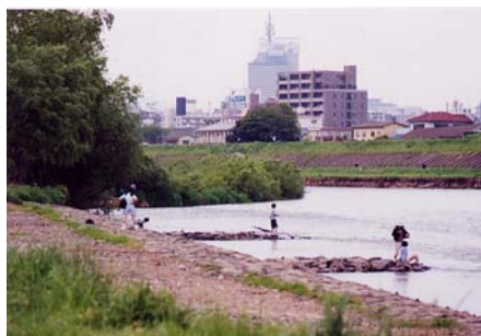
環境及び親水性に配慮した水制工
