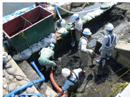
取水ポンプ場土砂撤去作業
