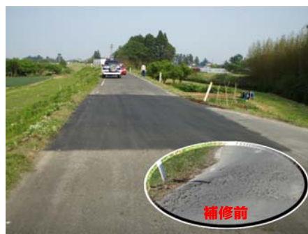
広瀬川堤防天端舗装状況
