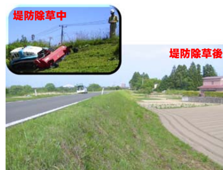
堤防の除草状況
