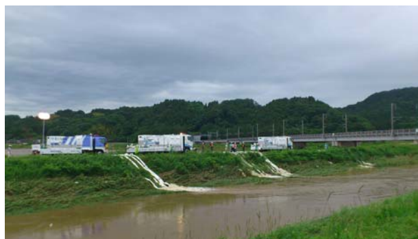
排水ポンプ車の活動状況
