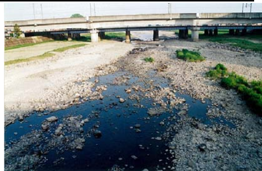
平成 6 年渇水時写真(広瀬川)
