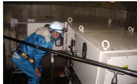
放流設備の点検
