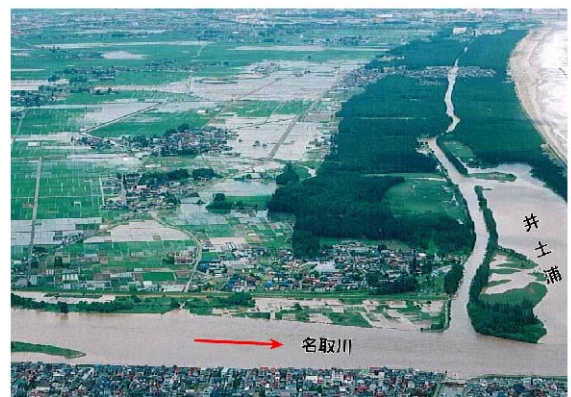
名取川下流部左岸の浸水状況
