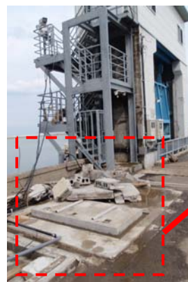
津波による発電機の流出状況
