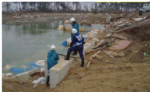
TEC-FORCE の派遣状況 (H23.4.11 井土浦川付近)
