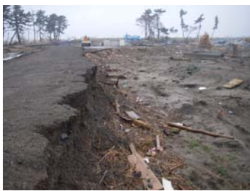
被災状況 (河口から左岸 0.0k 付近、 仙台市若林区藤塚地先)
