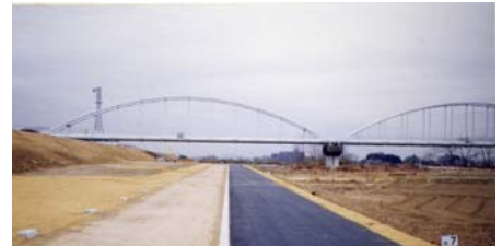
緊急河川敷道路
