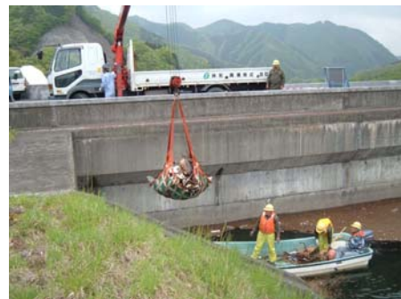
釜房ダム 流木処理
