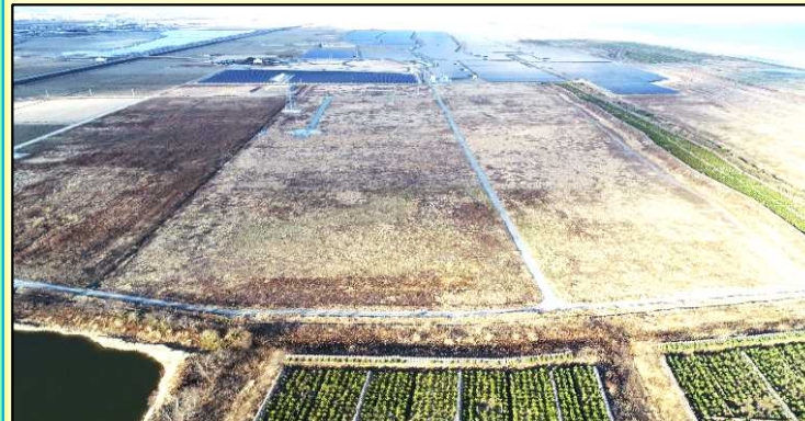
津波被災地域の雇用創出のため、ほ場整備事業の換地手法を用いて創出した土地へ立地企業を誘致し、地域経済の更なる発展を目指す。今回の土砂活用で、約13haに及び基盤造成を実施していく。〔写真：亘理町〕
