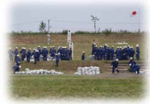
(積み土嚢(ど)のう)工法)
