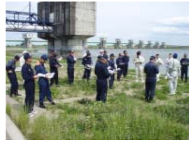
【重要水防箇所点検】
