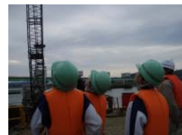
【工事現場見学中】
