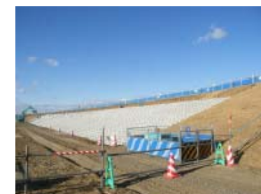
【堤防補強工事中】
