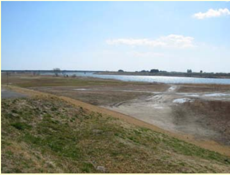
押分地区工事用坂路撤去
