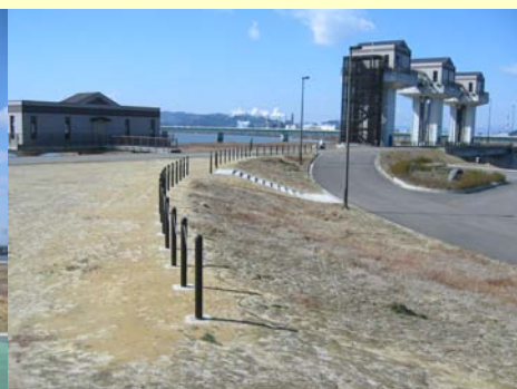
学水館と排水機場の連絡階段と柵
