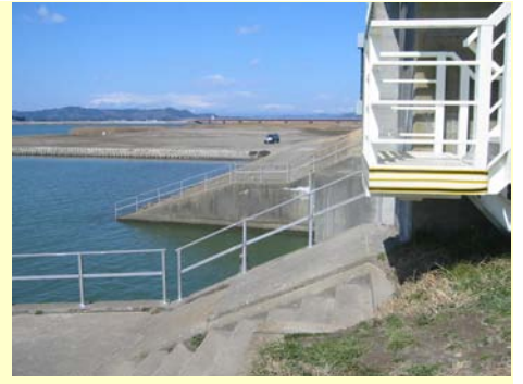
新浜水門ステンレス手摺り
