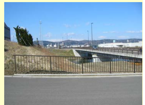
沈砂池の進入防止柵
