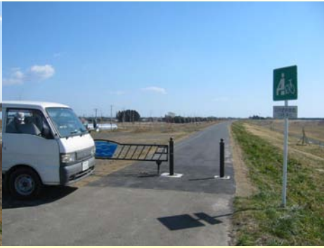
堤防天端舗装打ち替え
