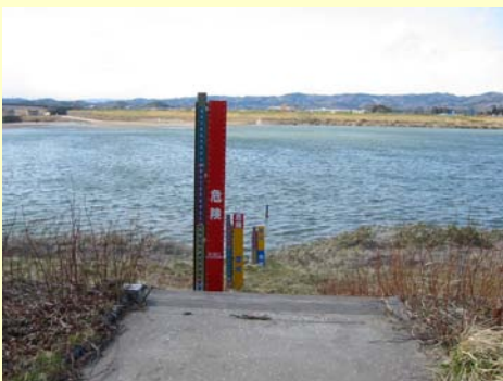
小山水位観測所危険標識設置
