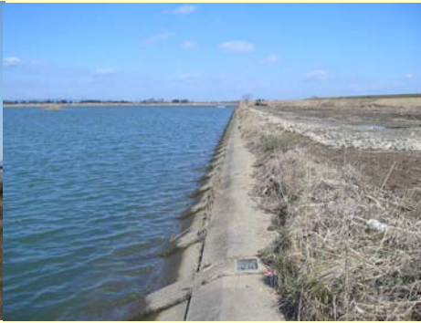
寺島護岸修繕・根固め投入
