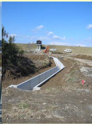
前田排水樋管の堤外水路
