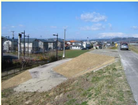
三名生排水樋管の駐車帯
