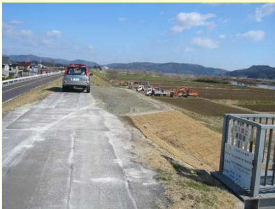
五間堀排水樋管の駐車帯
