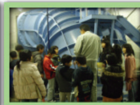
排水ポンプは飛行機と同じエンジンで動いています
