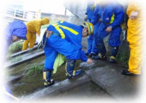
【白石川鉄道橋】
