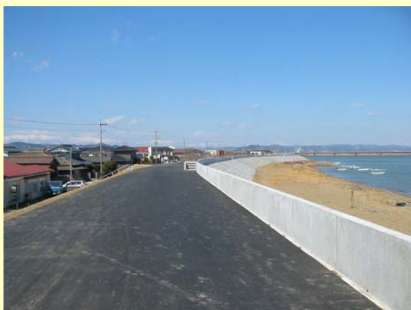
阿武隈川下流荒浜地区堤防天端工事
