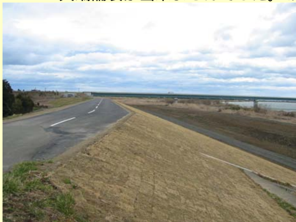
阿武隈川押分地区堤防整備工事
