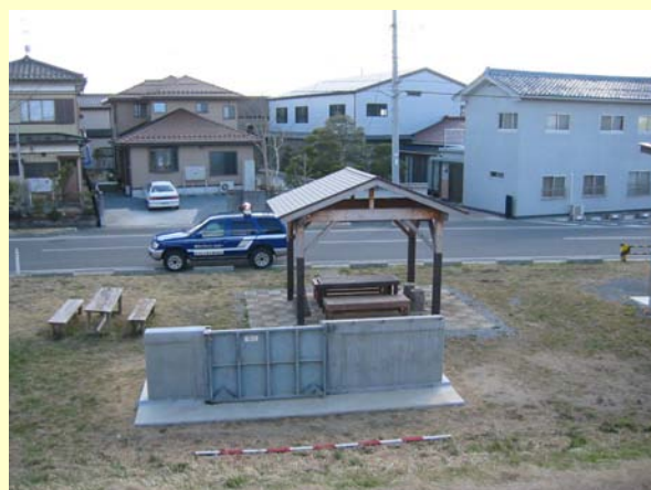
復元：荒浜第一陸閘
