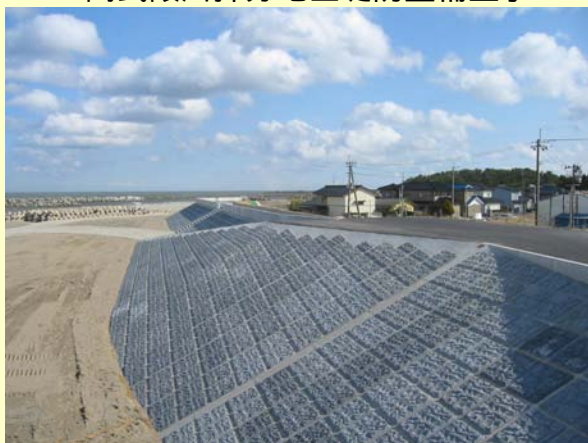
阿武隈川下流荒浜地区築堤工事
