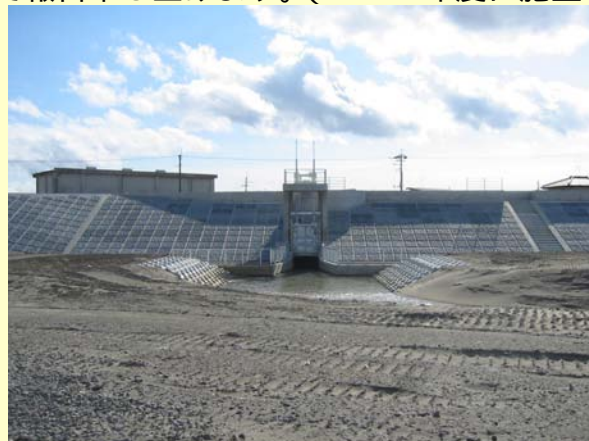
阿武隈川下流荒浜地区排水樋管工事
