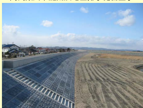
阿武隈川下流巨理地区築堤工事
