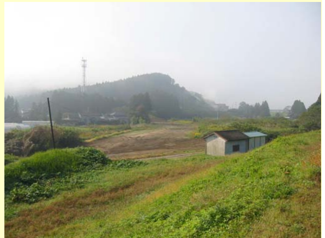
旧小山堤防（山付堤防）の土取り完了全景
