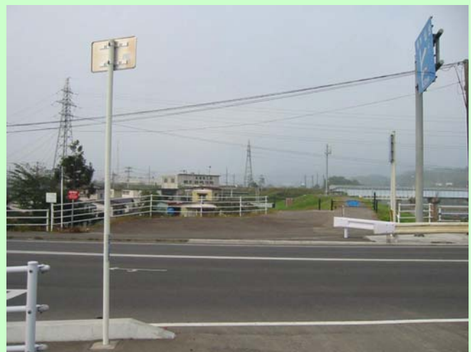
排水施設進入路（白石川右岸・白幡橋付近）
