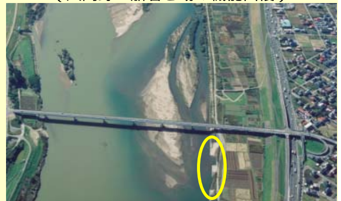
岩沼地区河川管理施設修繕工事の現場（左岸） （入間野・船着き場の機能回復）
