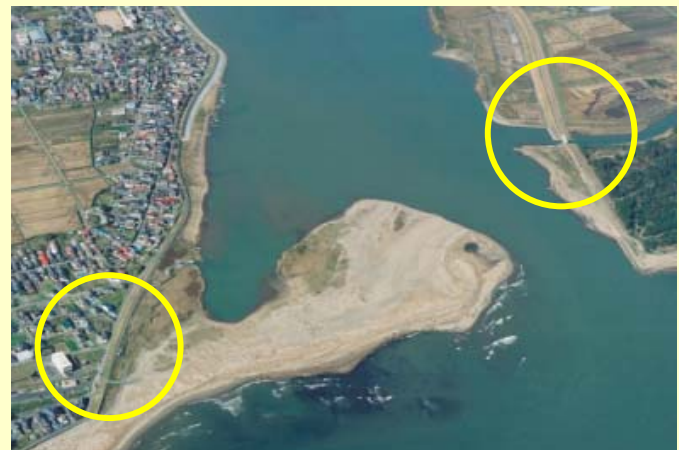
荒浜地区排水樋管工事の施工現場（右岸） 岩沼地区河川管理施設修繕工事の現場（左岸） （新浜水門付近の坂路設置及び堆積砂の撤去）
