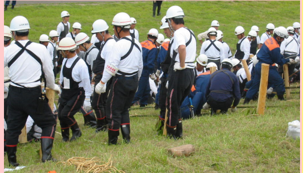
竹を利用した伝統工法のカゴ止め工法
