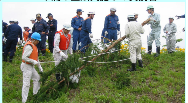
木流し工法実施中の受講者
