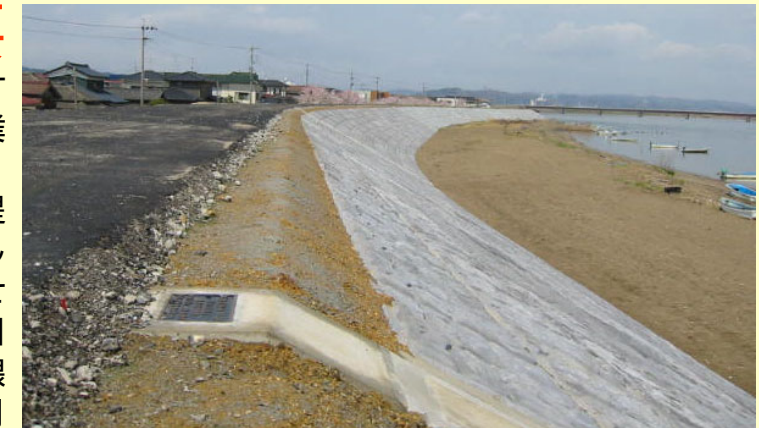
荒浜築堤・平成16年度150m完成、残610m
