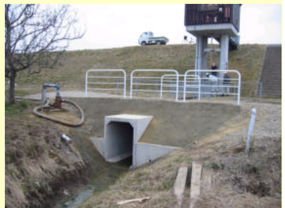
前田排水樋管前の管理用通路
