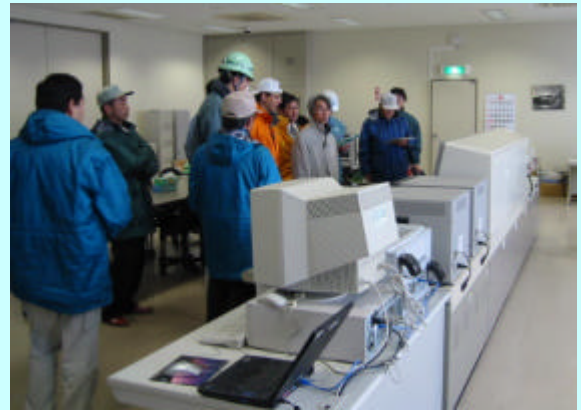
排水運転中の表示盤を確認する関係者
