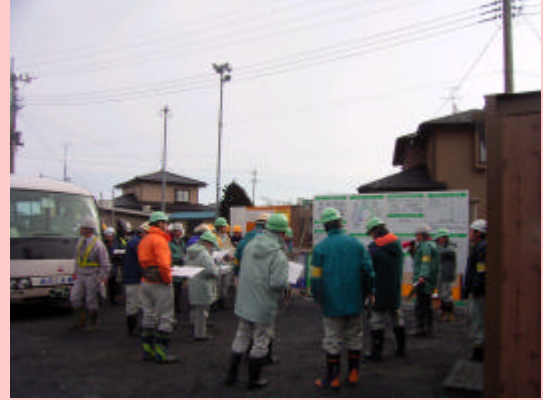
「阿武隈川荒浜地区築堤工事」 現場事務所前で現場代理人が説明 【安全第一!!】
