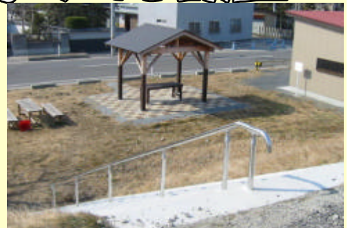
東屋付近に設置された階段手すり
