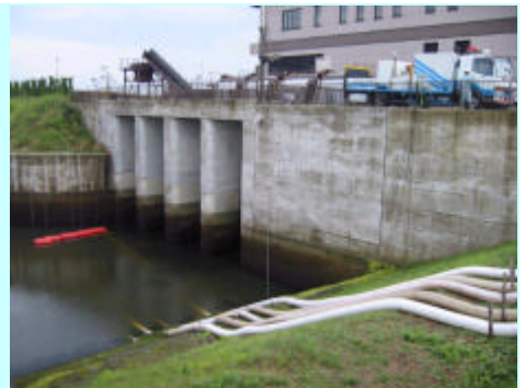
沈砂池の順調な排水作業時
