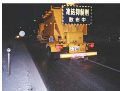
【凍結抑制剤の散布状況】
