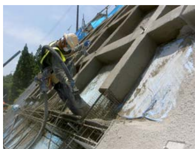
【法枠工施工中】
