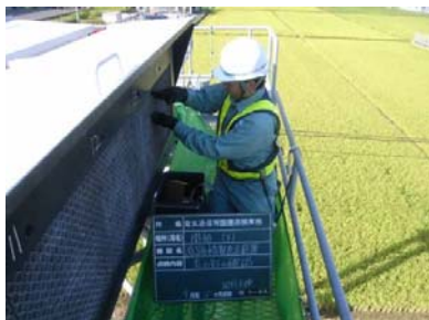
【道路情報板の点検状況】
