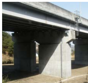
【対策後：橋脚補強】
