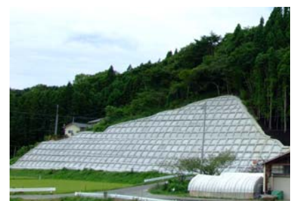
【法枠工による法面保護】
