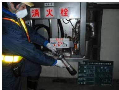
【トンネル非常用施設の点検状況】
