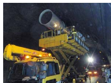
【トンネル換気設備の点検状況】
