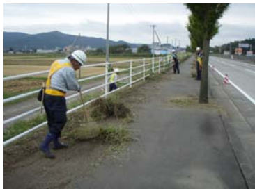
【除草作業の状況】
