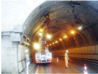
【トンネル点検の状況】
