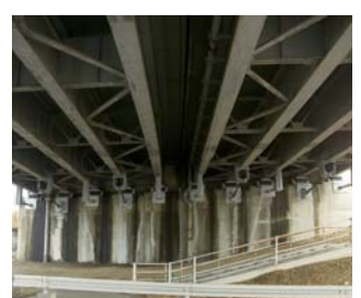
【対策後：落橋防止システム】
