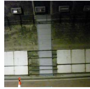
【導水工による補修】
