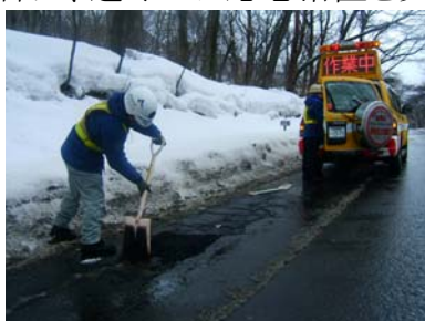
【路面の応急補修】
