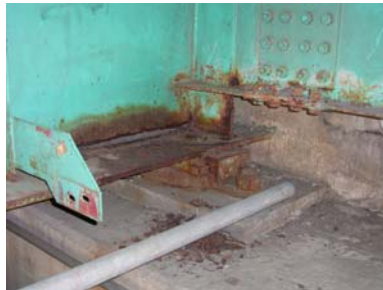
【鋼材破断】
