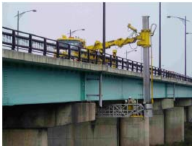
【橋梁点検車による点検】
