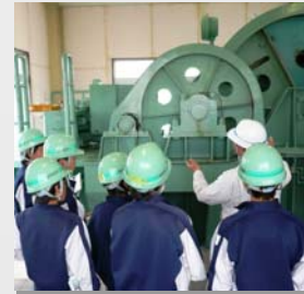
ゲートを動かす巻き上げ機の説明を聞いているところ
