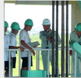
ゲートを上げ下げするワイヤロープを点検するところ
