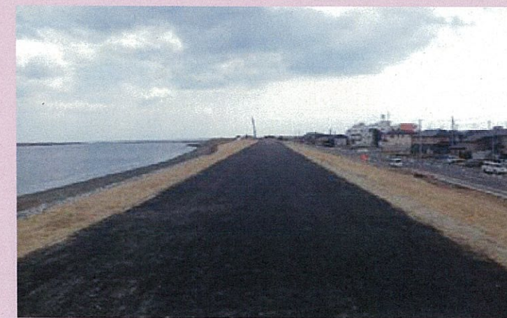
【本復旧後 平成29年時点 完成】
