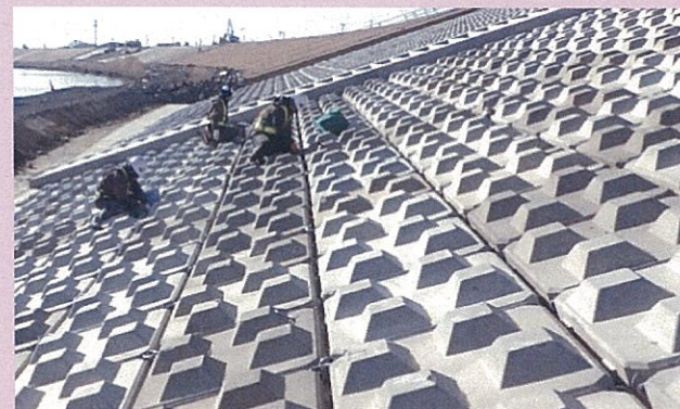
【②コンクリートブロック】
