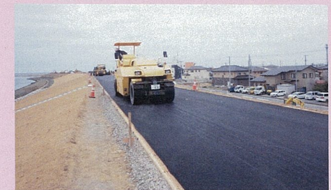
【⑤天端舗装】
