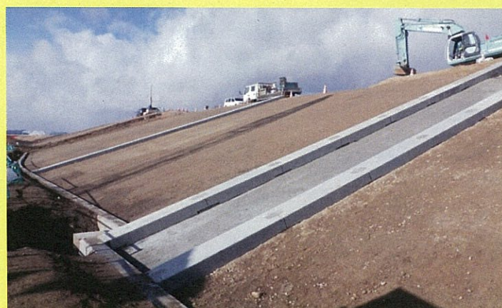
【法面整形完了】
