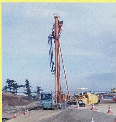
【サンドコンパクションパイル施工状況】
