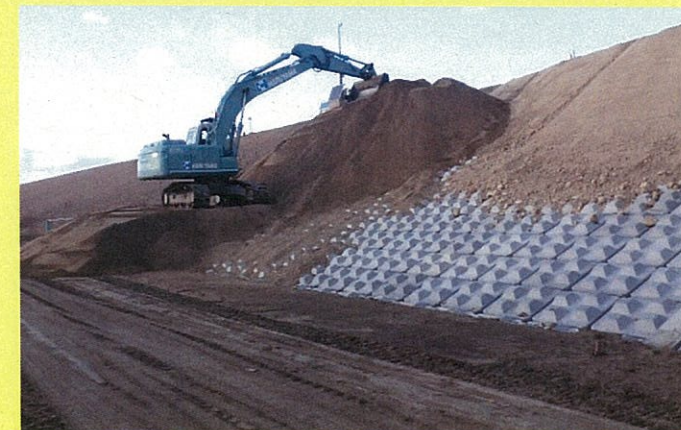
【覆土施工状況】
