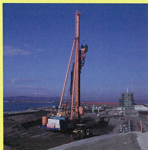
【サンドコンパクションパイル施工状況】
