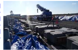
ブロックを型枠から外してクレーン車で移動
