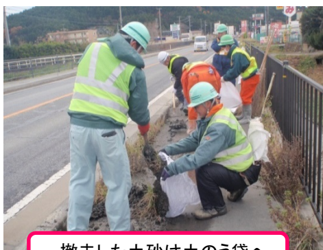
撤去した土砂は土のう袋へ
