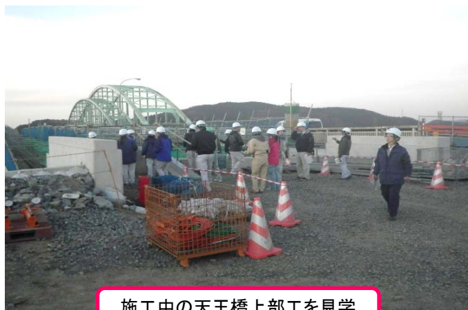
施工中の天王橋上部工を見学
