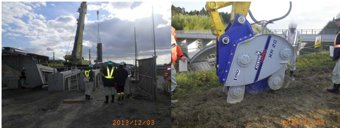
現場点検の様子
