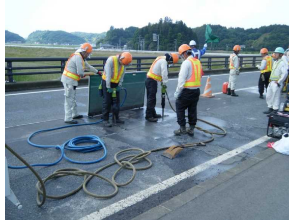
●応急処理工（橋梁床版補修）
