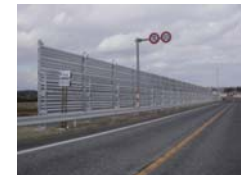
防雪柵整備状況
