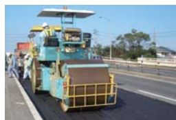
舗装修理状況
