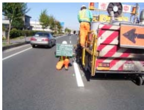
車線境界線(破線)を引いてます。
