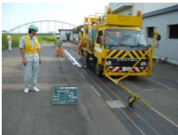
車線境界線(破線)を引いてます。
