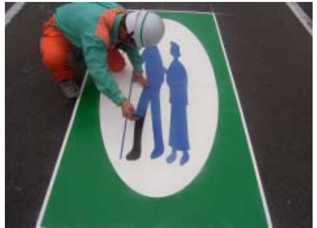
シート設置状況
