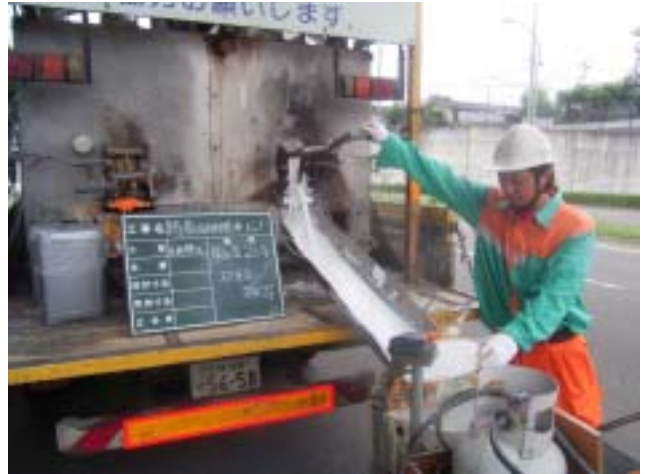
熱で溶かした材料を施工機に入れてるところ
