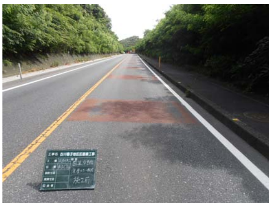
薄層カラー舗装 施工前
