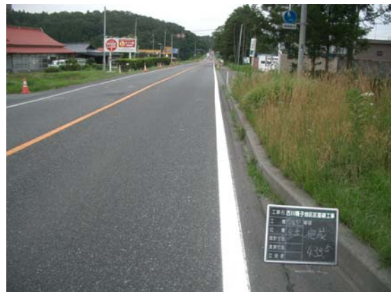
外側線 施工後
