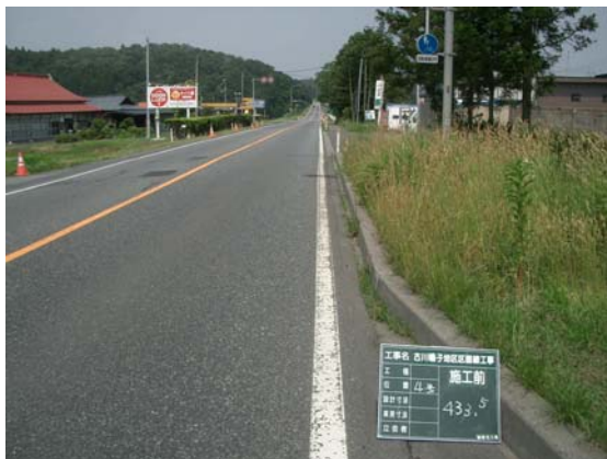
外側線 施工前
