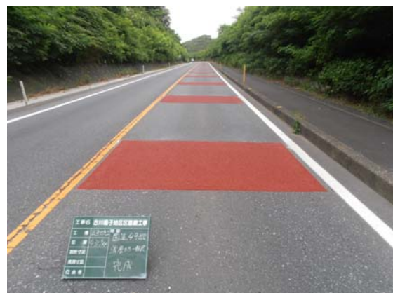
薄層カラー舗装 施工後
