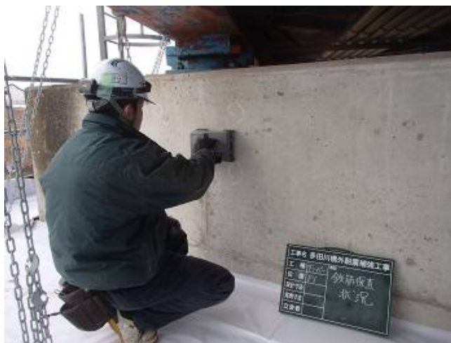
鉄筋探査状況 (P1)
