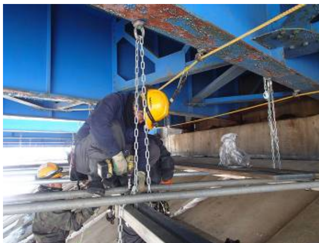
足場組立状況 (A2)
