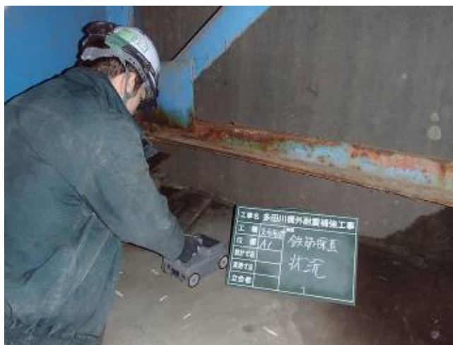
鉄筋探査状況 (A1)
