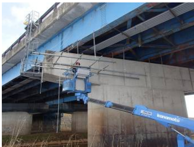
足場組立状況 (P1)
