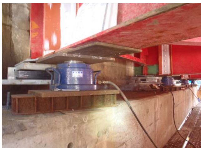
主桁ジャッキアップ・支承取り付け状況(A1橋台)
