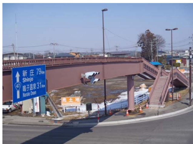
施工完了(47号線上)
