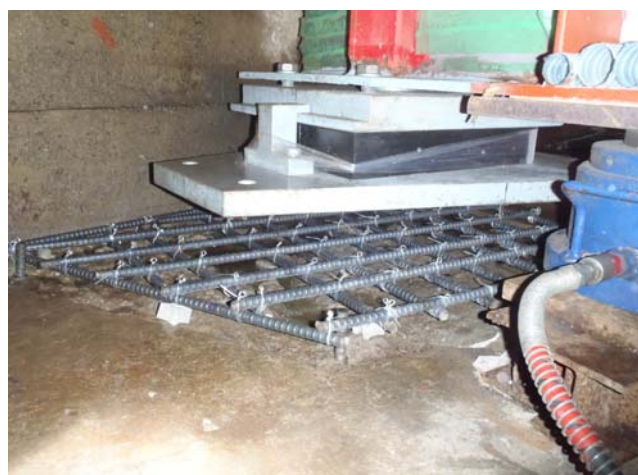
台座鉄筋組立(A1橋台)
