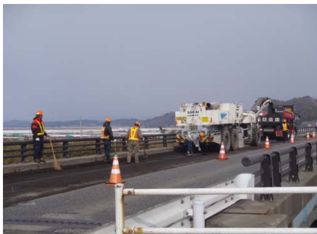
橋面舗装撤去(橋面上)
