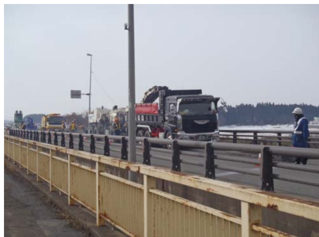
橋面新舗装敷設(橋面上)
