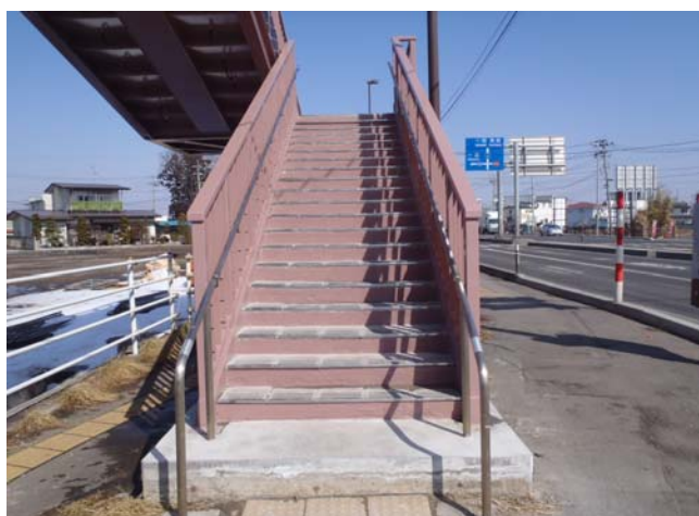
階段補修完了(47号線築館側)
