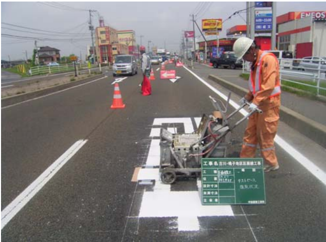
文字施工状況
