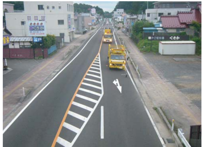
外側線引き直し
