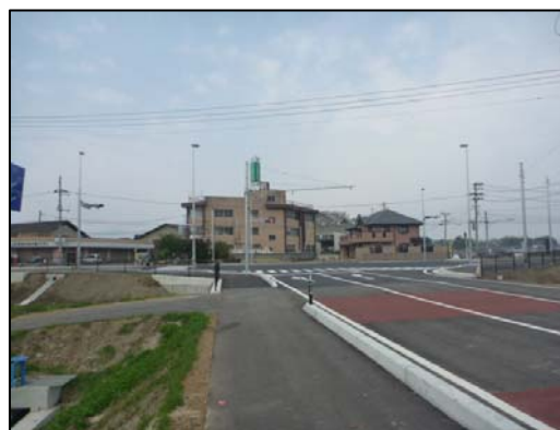
村道野畑松本線交差点付近 (村道から国道側を撮影)
