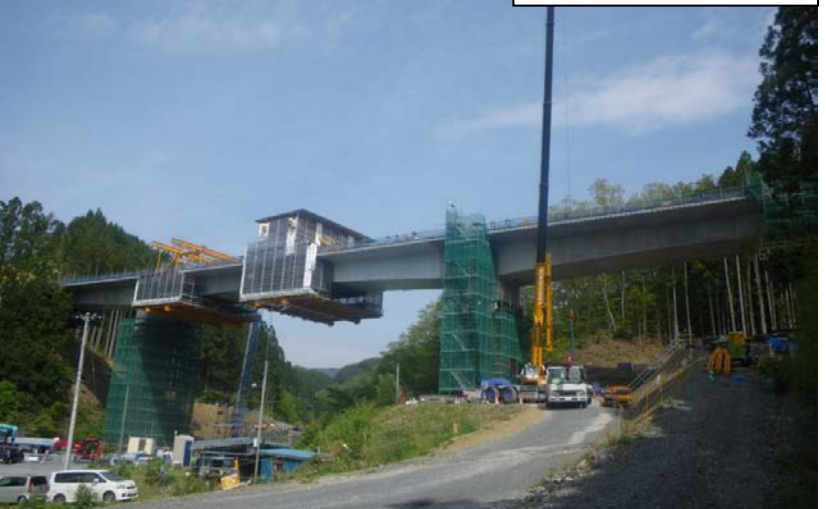
③ 右側からP1、P2を望む (仮)大上坊川橋上部工
