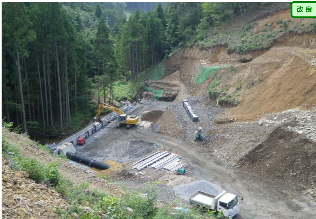
② No.128付近(補強土壁工)
