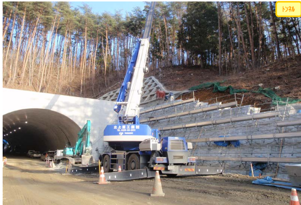
② 起点側から終点側を望む
