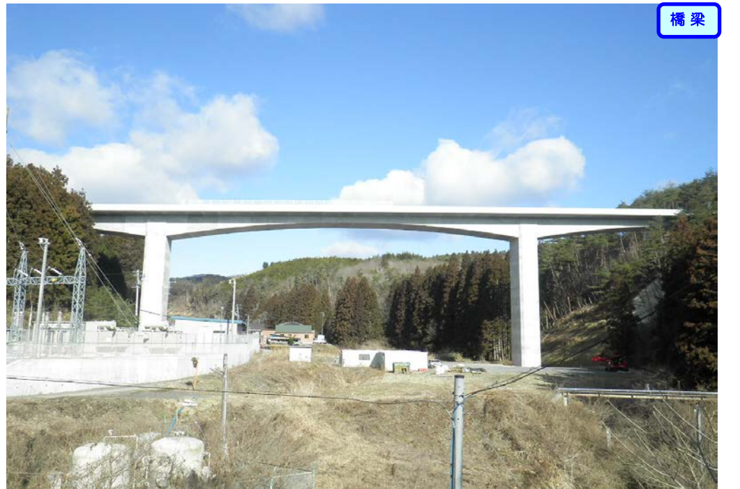
③ 国道45号から橋梁右側を望む 新井田川橋
