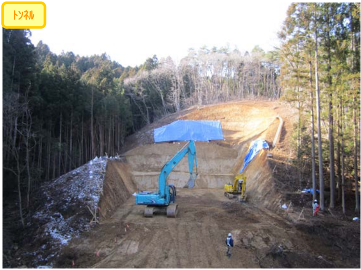
② 1号トンネル 終点側坑口全景
