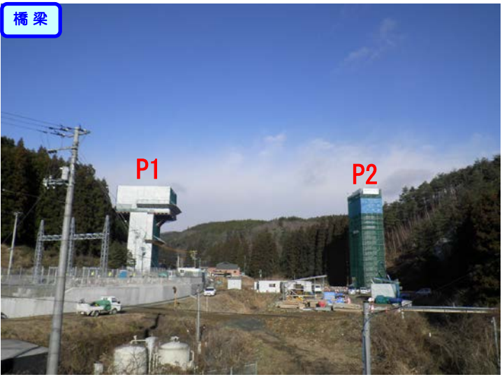
④ 国道45号からP1、P2を望む 新井田川橋
