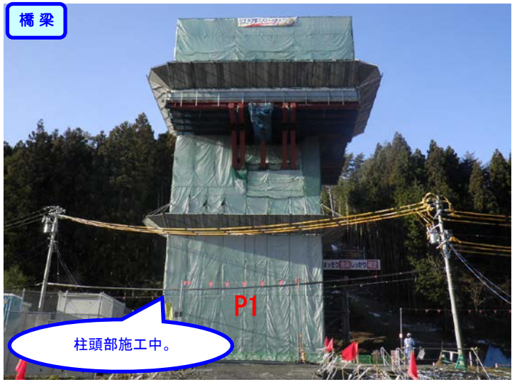
③ 終点側からP1を望む 新井田川橋
