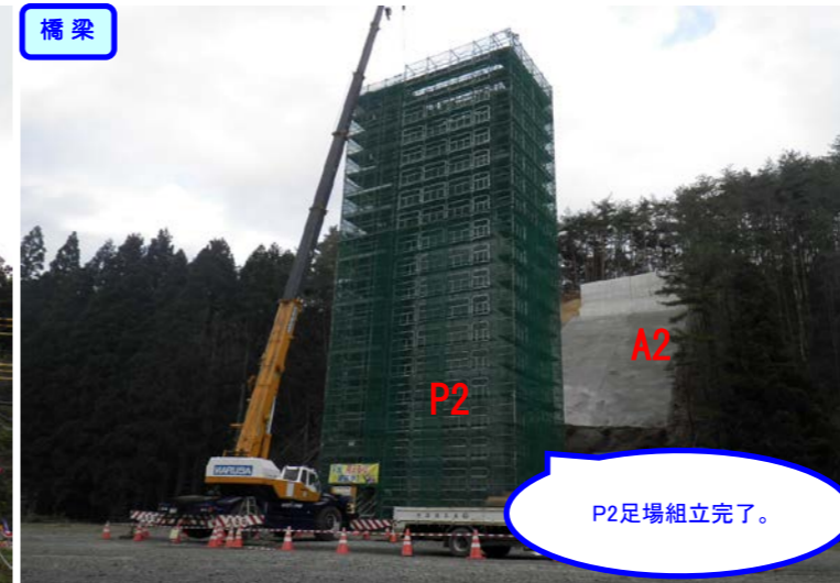
④ 起点側からP2、A2を望む 新井田川橋
