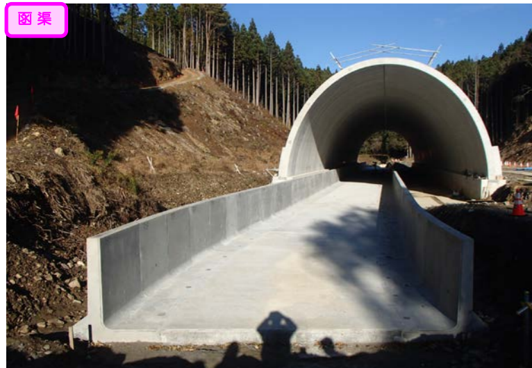
② 4号函渠 擁壁護岸工
