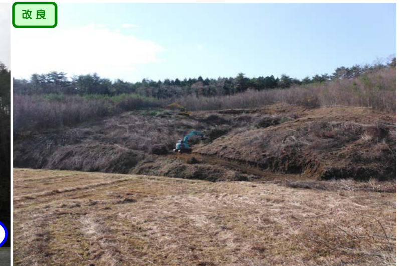
⑤ No.167から起点側を望む
