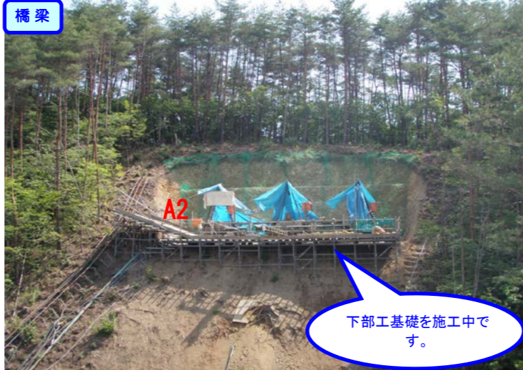
④ A2深礎工
