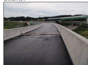
② Cランプ No.-23より起点方向 基層施工完了
