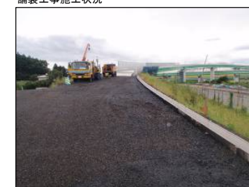
⑲ Bランプ No.-43より終点方向 舗装工事施工状況
