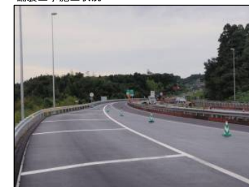
⑨ 三陸道本線No.263より終点(石巻)方向 舗装工事施工状況
