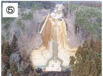
⑤ H30.02.25撮影 工事用道路が完成しました。
