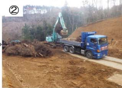
② H30.11.30撮影 伐採後の根株をバックホウで抜根しました。
