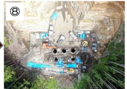
⑧ R01.06月末撮影 現在の現場状況です。
