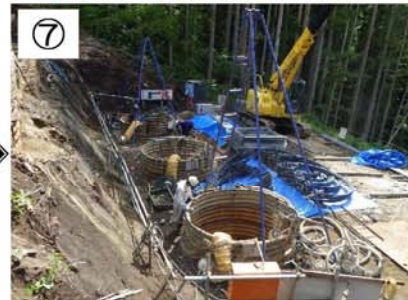
⑦ R01.06.27撮影 深礎杭の鉄筋組立を行っています。
