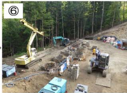
⑥ R01.05.14撮影 深礎杭の掘削を行っています。
