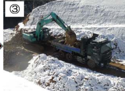
③ H30.12.14撮影 深礎杭・橋台を造るための、工事用道路を作成しています。
