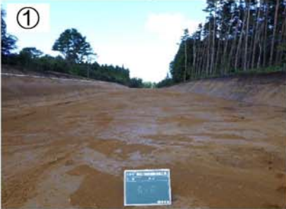
① H30.10.02撮影 工事着手前の小山川付近の現地状況です。
