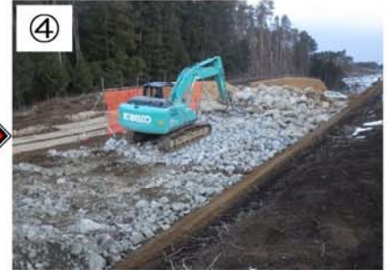
④ H30.12.26撮影 盛土に使用するため、転石を破碎処理しています。
