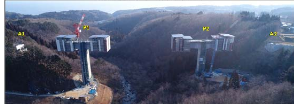
H31.2.26撮影 ドローンによる空撮。 P1-第4ブロック施工中、P2-第6ブロック施工中。(全18ブロック)
