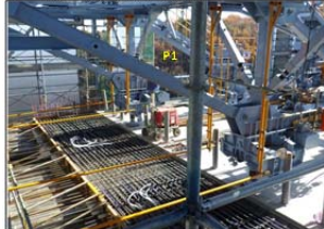
H30.11.22撮影 型枠・鉄筋を組み立てています。 写真は第1ブロック施工時です。
