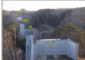
H30.1.16撮影 A1橋台背面から撮影。 (橋梁下部工完成写真)
