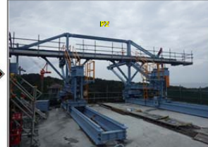
H30.9.25撮影 ワーゲン(移動作業車)と足場を組み 立てています。
