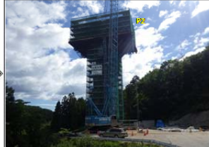
H30.6.25撮影 ブラケット支保工による足場組立後、 柱頭部の施工を行いました。
