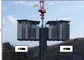
H31.1.31撮影 コンクリート打設後、ワーゲンを移動 させ、繰り返し型枠・鉄筋を組み立てる 張出施工のサイクルに入っています。
