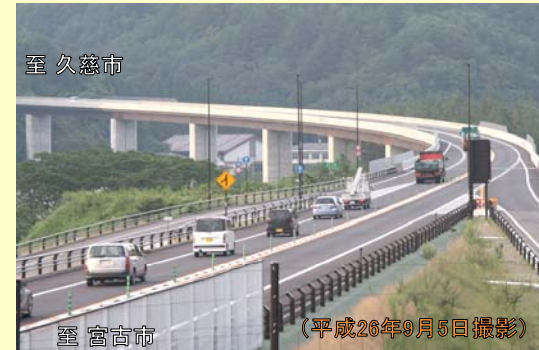
▲ 普代道路の通行状況
