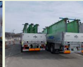
② 橋桁の運搬作業状況
