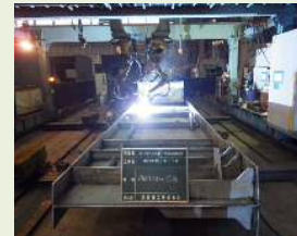
① 工場での桁製作の状況
