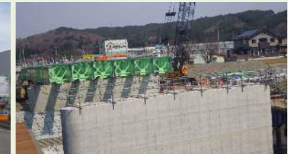
③ 橋桁の架設作業状況
